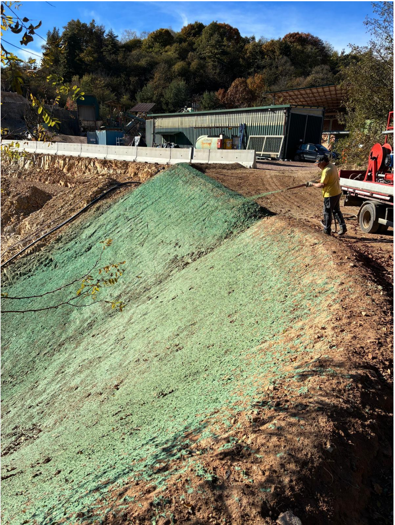
Figura 25 - Settore E Idrosemina scarpate a monte vasca di depurazione
