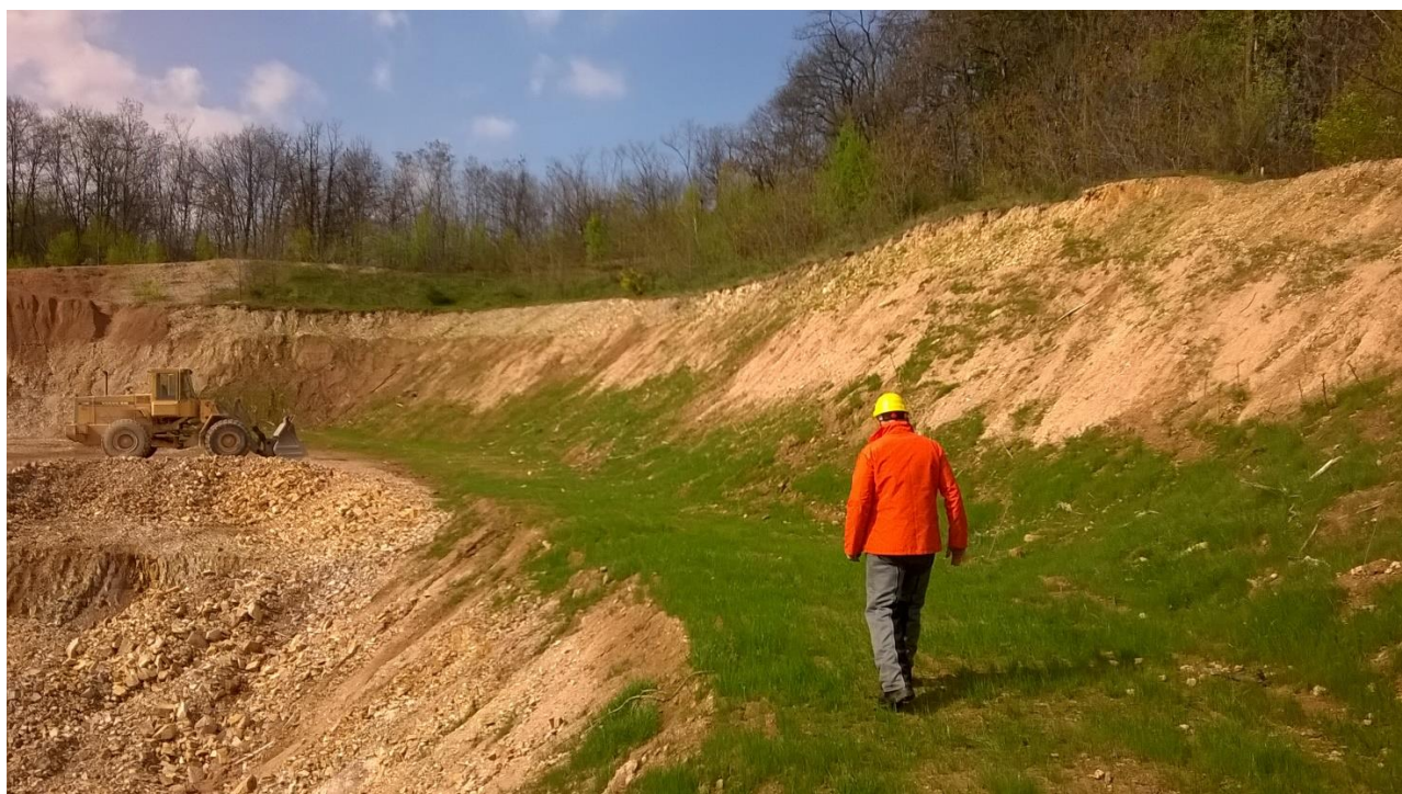
Figura 5 - Settore di scavo NW - Recupero gradone e scarpate con inerbimenti
