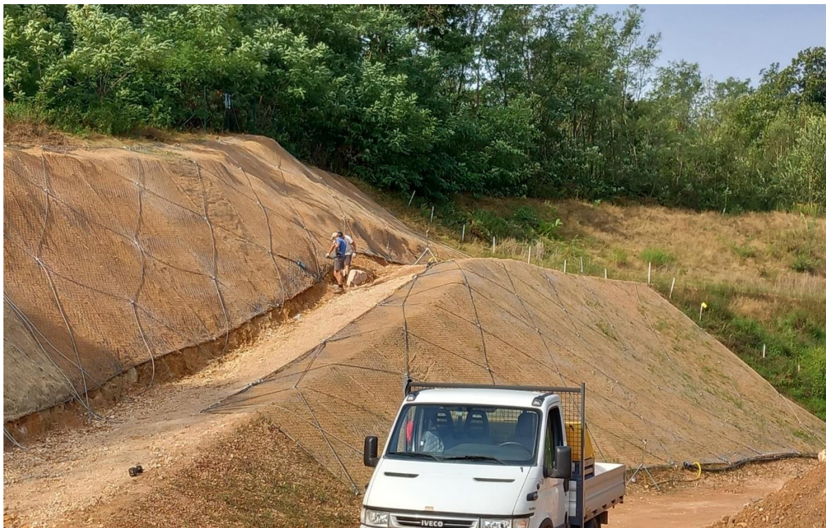
Figura 20 - Settore W posizionamento rete biodegradabile fissata con cavi di acciaio - scavo al piede delle scarpate del fosso di raccolta acque meteoriche.
