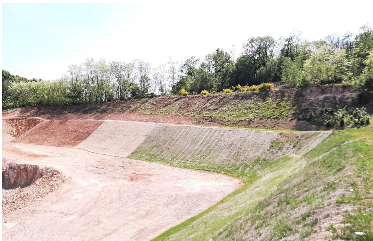
Figura 16 - Settore NW area in corso di recupero con inerbimenti mediante idrosemina
