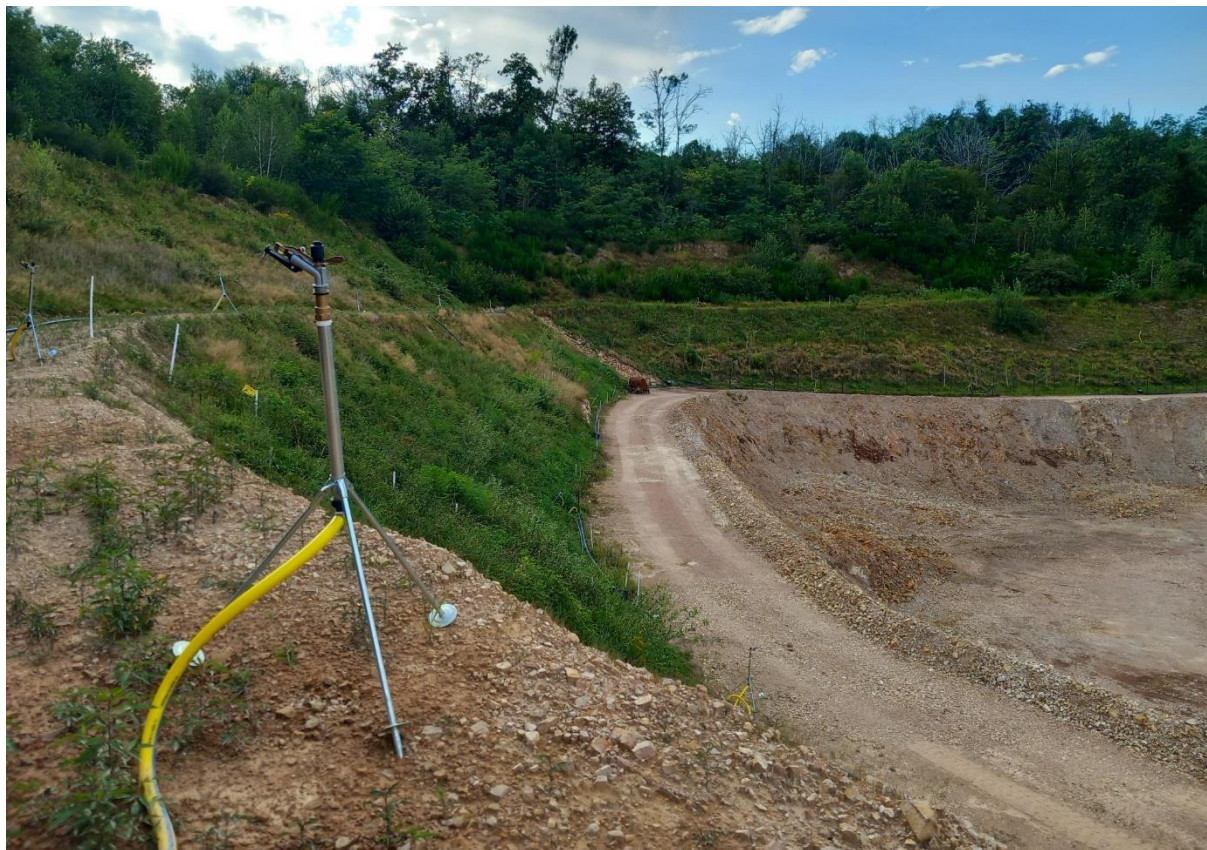
Figura 19 - Settore W - Impianto irriguo a pioggia
