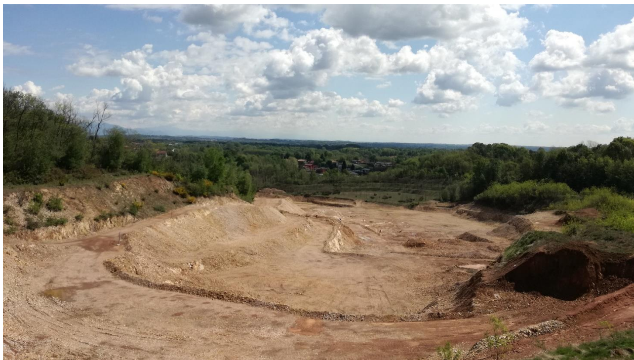
Figura 13 - Vista da W. In primo piano, cumuli terreno fertile di scotico da utilizzare per i recuperi
