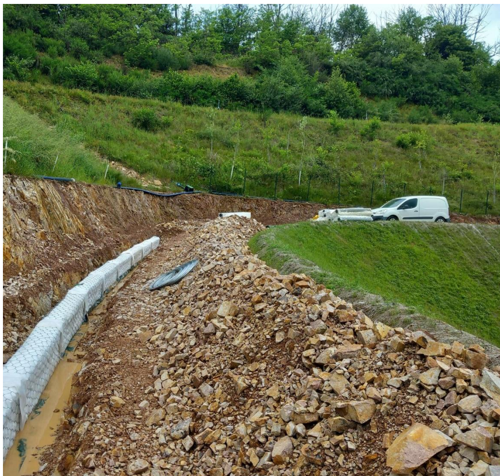
Figura 23 - Settore W Scavi e posa dreni per captazione acque meteoriche per evitare erosioni. L'acqua viene captata e utilizzata per l'irrigazione delle aree recuperate.
