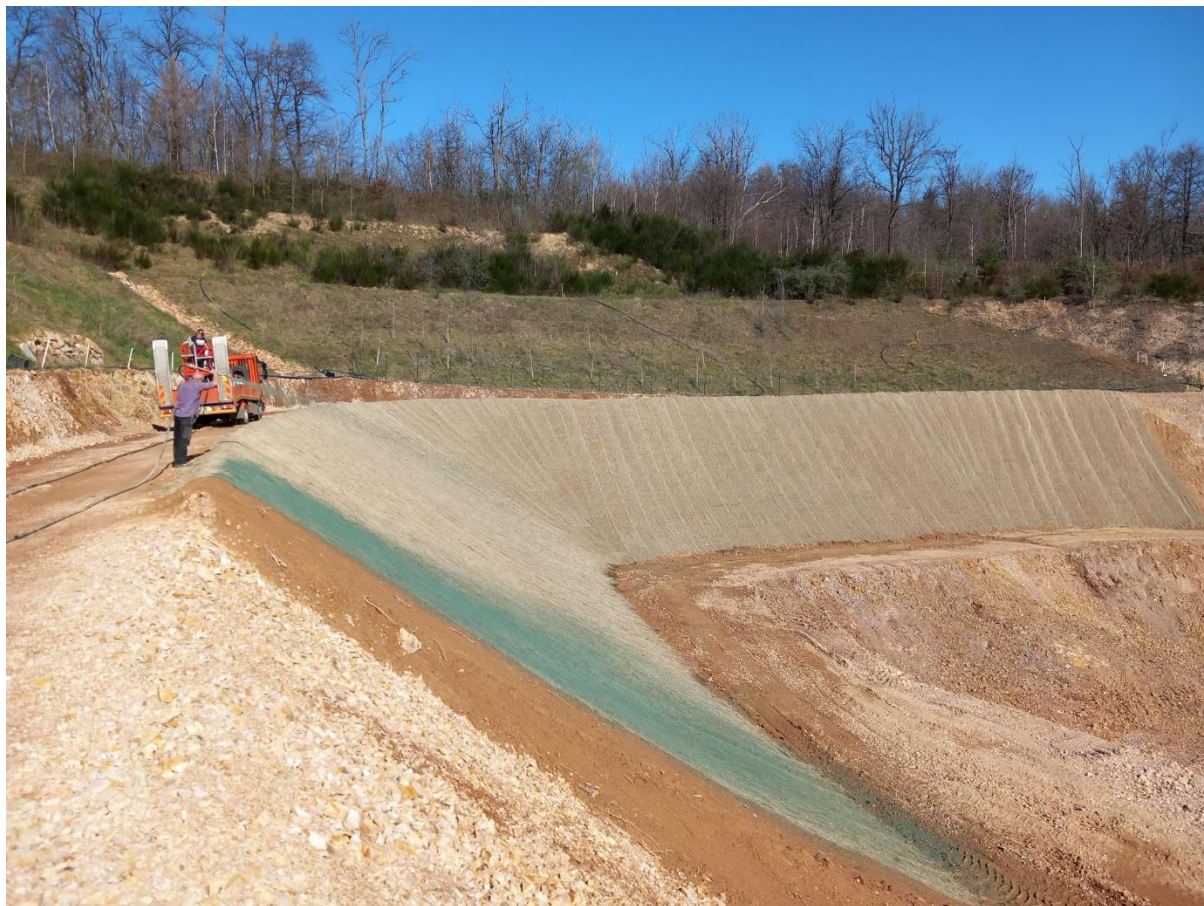
Figura 21 - Settore W –Recupero scarpate secondo gradone con riporto terreno fertile, posa rete biodegradabile e idrosemina
