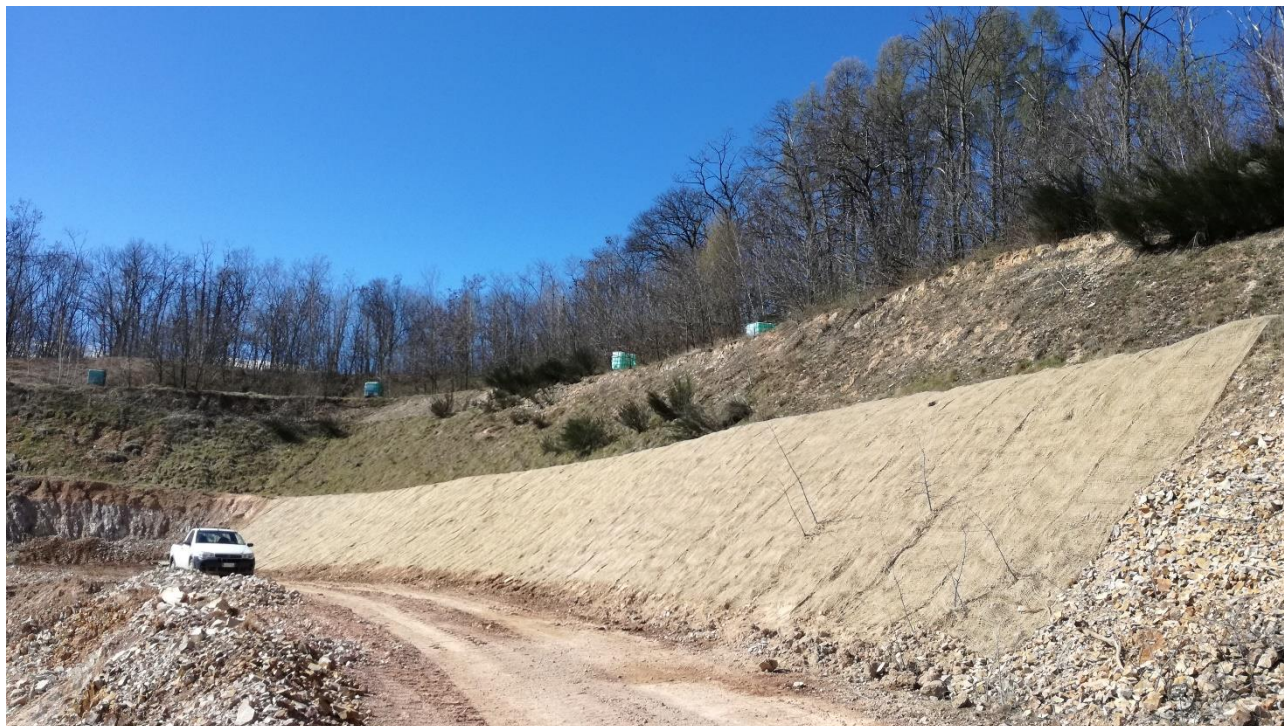
Figura 11 - Settore NW posizionamento biorete degradabile per evitare erosioni
