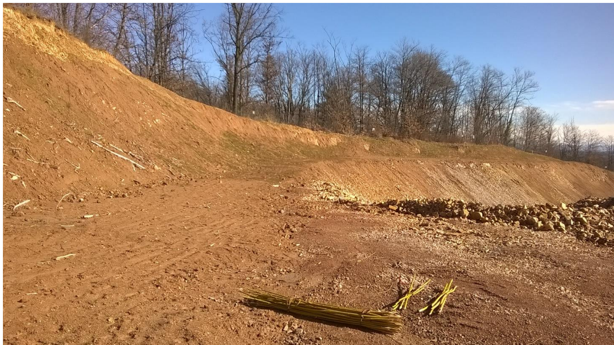
Figura 4 - Settore di scavo NW recupero gradoni e scarpate con riporto terreno fertile di scotico. In primo piano talee di salici da mettere a dimora.
