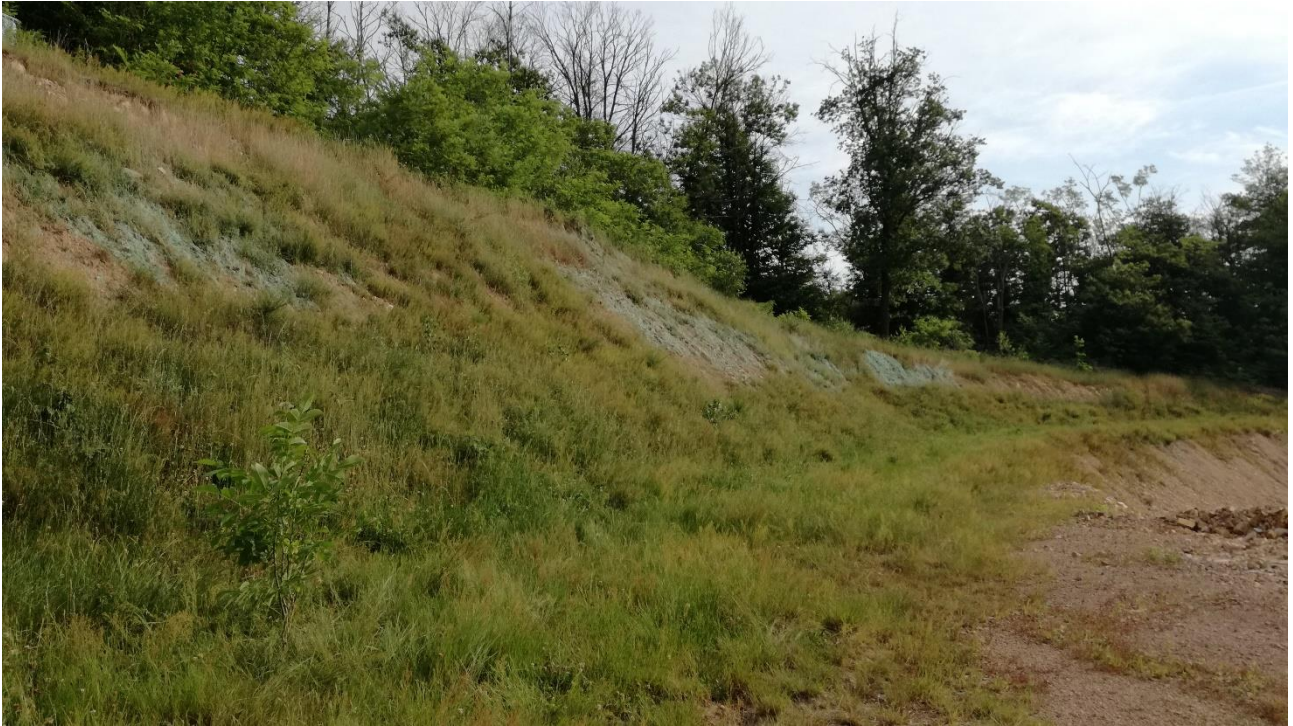
Figura 9 - Settore di scavo W integrazioni inerbenti con idrosemina
