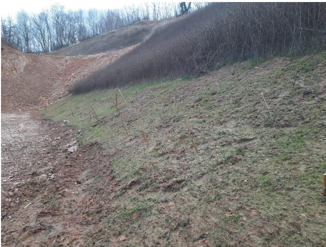
Figura 28 - Settore NW. Piantumazione talee salici ( Salix alba var. vitellina ) fondo scarpate secondo gradone.
