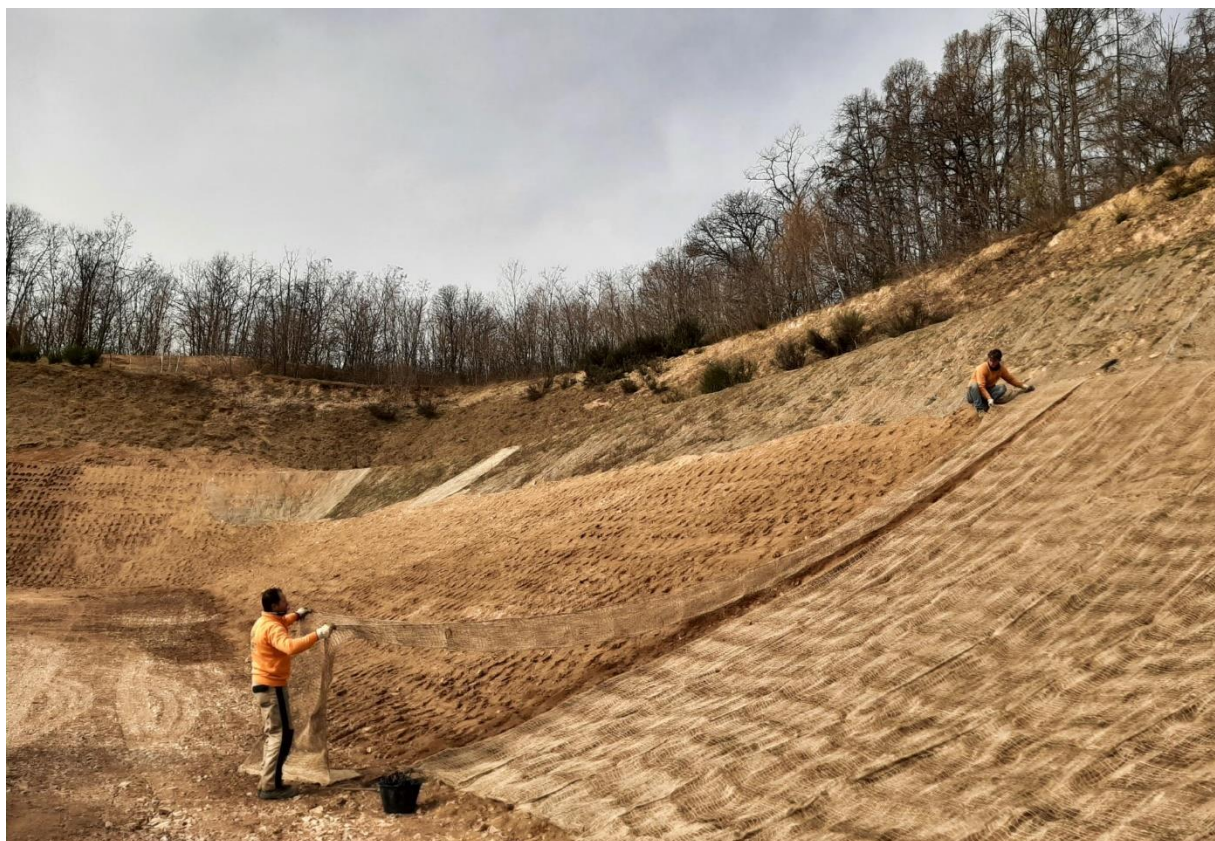
Figura 15 - Settore NW Posizionamento biorete degradabile per evitare erosioni
