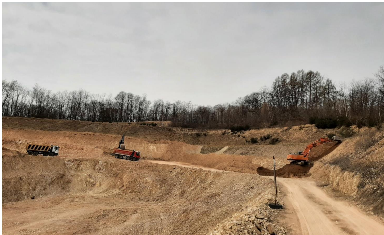
Figura 14 - Settore NW Scavi e riporto terreno fertile su scarpate per recupero
