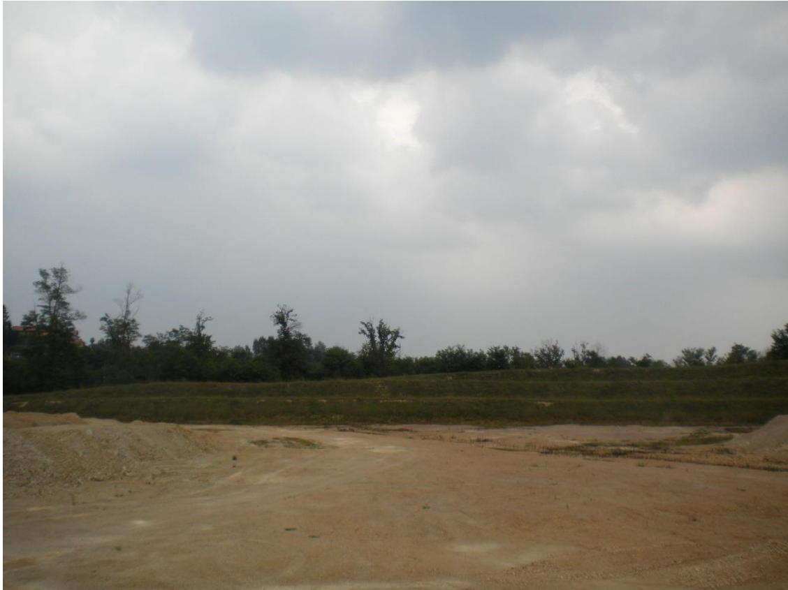
Figura 2 - Settore di scavo W con formazione gradoni e inerbimento.
