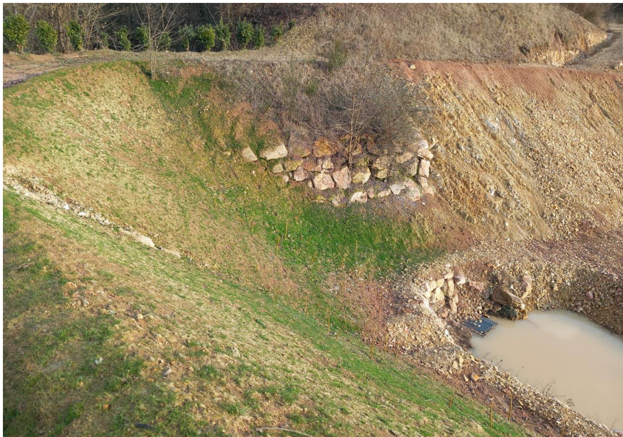
Figura 26 - Settore NE Scarpate recuperate a monte vasca di decantazione acque meteoriche Sullo sfondo sviluppo siepe di Lauro nobilis per contenimento polveri
