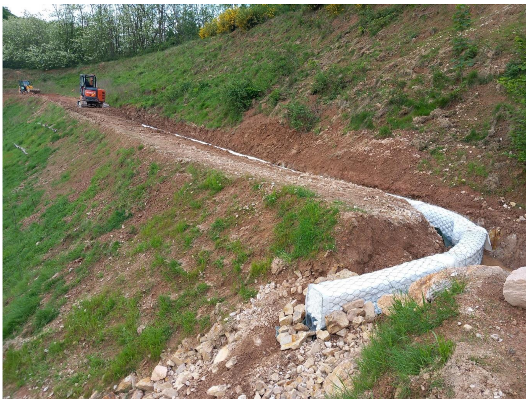
Figura 18 - Scavi e posa dreni per captazione acque meteoriche per evitare erosioni. L'acqua viene captata e utilizzata per l'irrigazione delle aree recuperate
