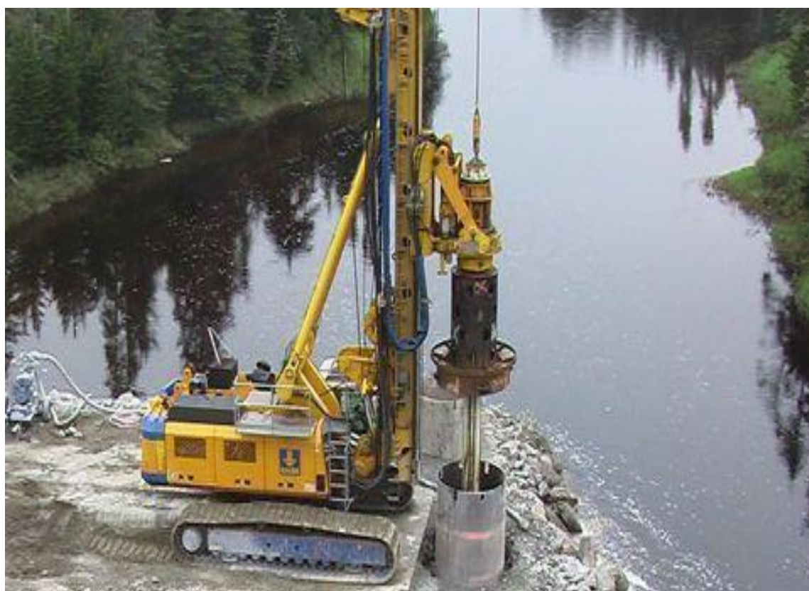
Figura 9: Formazione di pali di fondazione in alveo.
