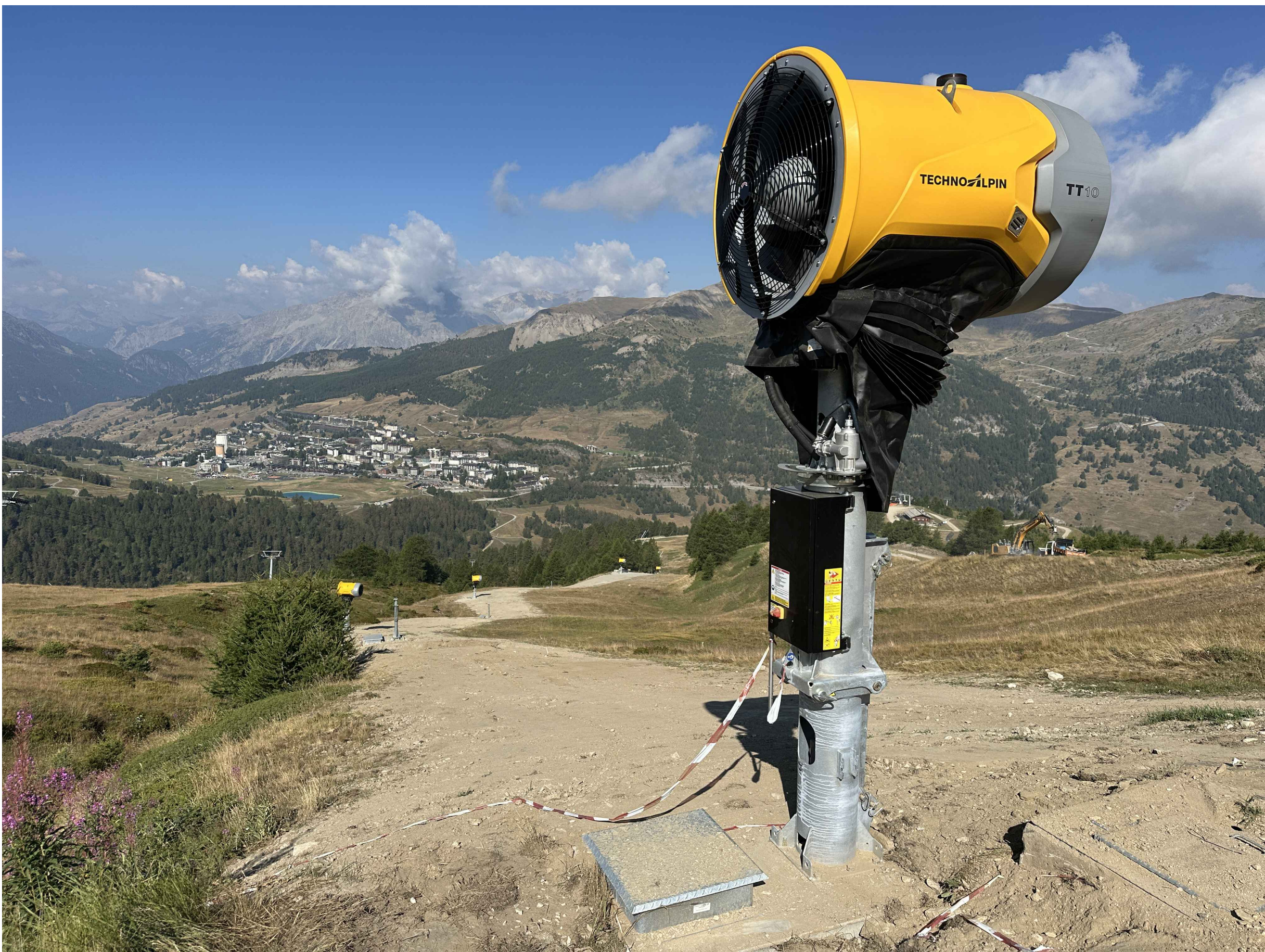
PARTICOLARE POZZETTO E GENERATORE T10
