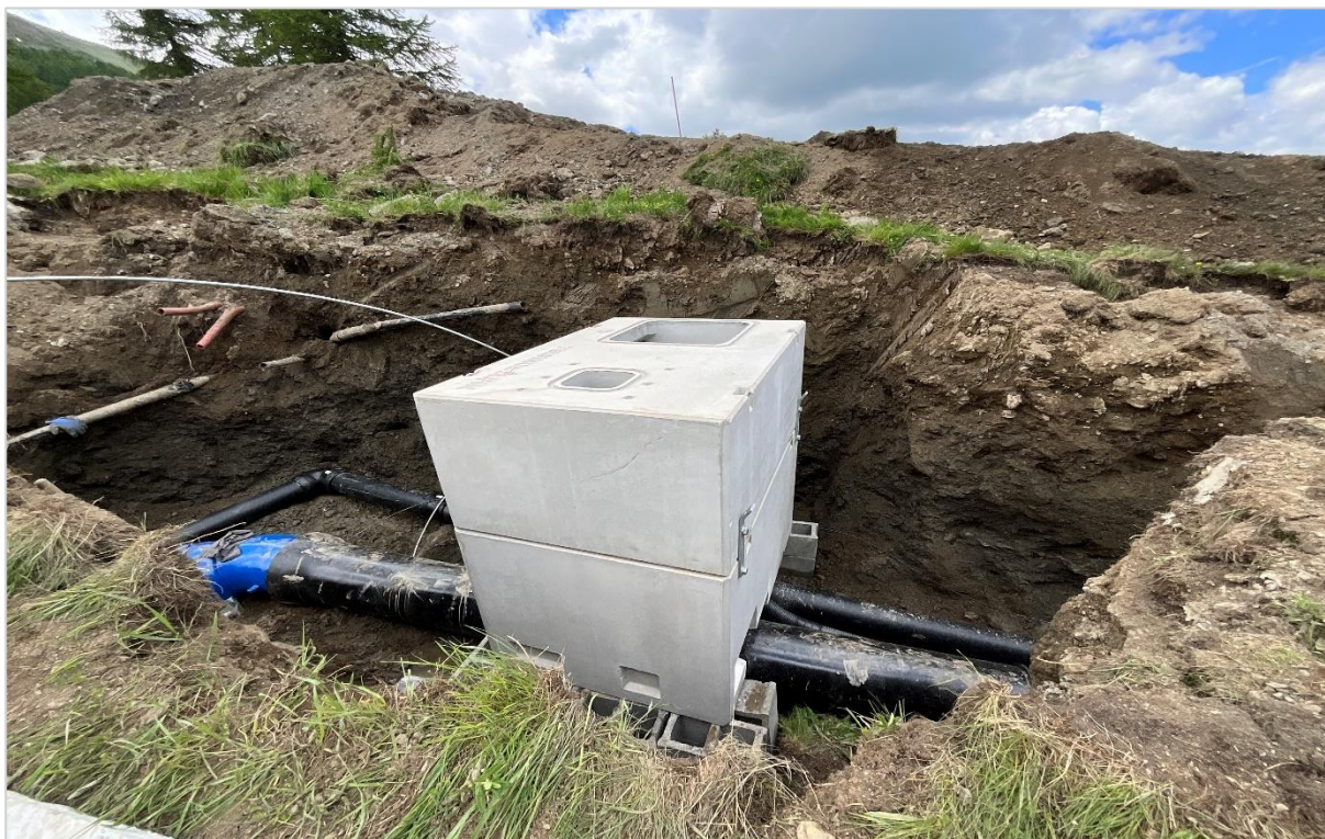
Figura 14 pozzetto posizionato
